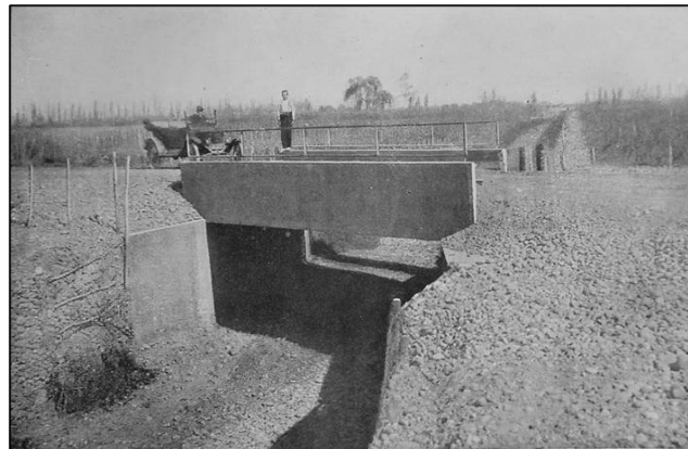
Ilustración 9- Puente sobre el “paso de la muerte” (Guaymallén). 1923
